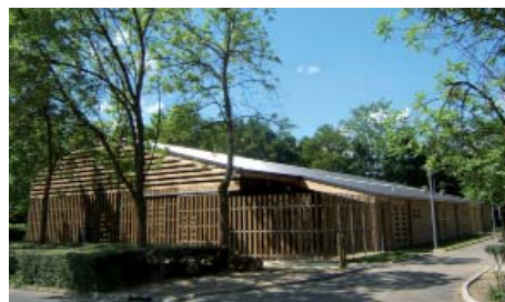
La salle polyvalente à Lagny-sur-Marne
